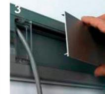
3 Se necessario inserire la blank cover nel profilo in alluminio.
