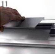
11 Dove necessario inserire la blank cover (tappo in alluminio) nel telaio.
