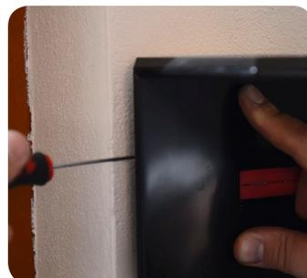
Fissare con le brugole laterali la cover sul sostegno in alluminio (svitare in senso antiorario i grani meccanici assicurandosi che la brugola non ecceda dall'inizio svasatura del blocchetto laterale).
