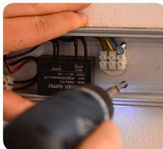
Fissare il telaio con viti e cacciavite.
